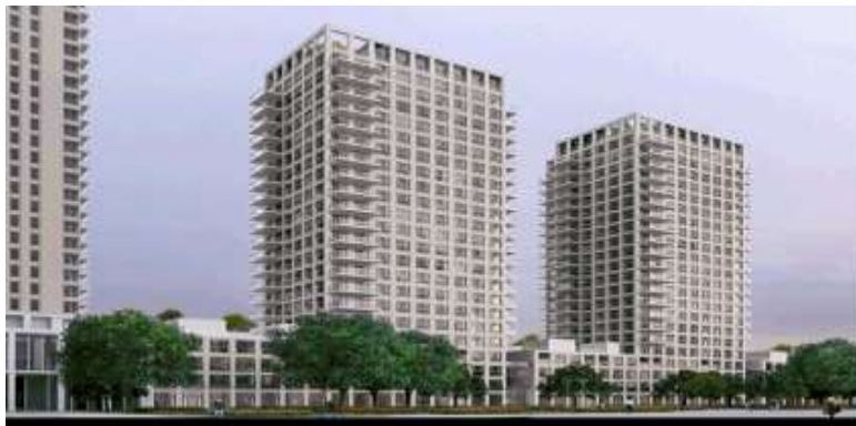
Zalmhaven - Holandia, Rotterdam
