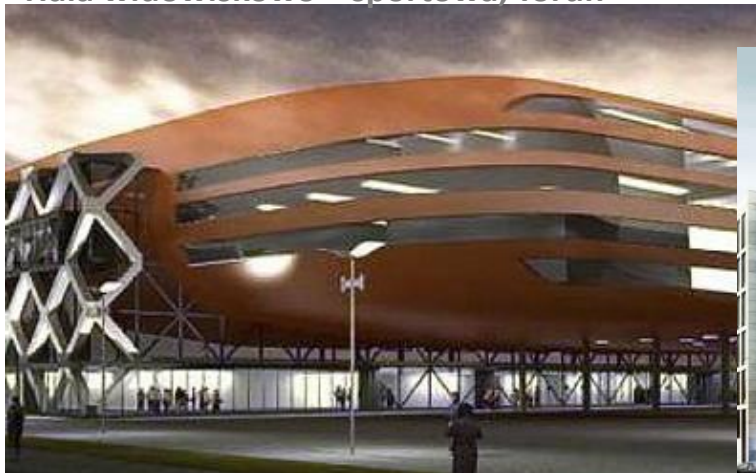
Hala widowiskowo – sportowa, Toruń
